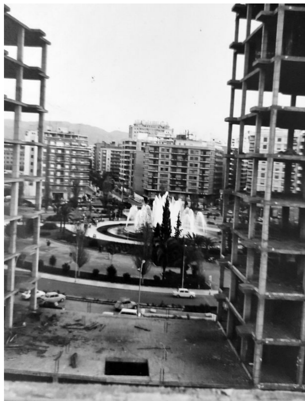
Vista de las obras de la casa parroquial y los edificios Torre-Naconsa y Sol, década de 1970.
